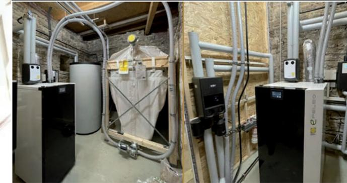
**Installiert wurde: Peleo 18 kW mit Sacksilo sowie 650 l Frischwasser-Pufferspeicher + 8m<sup>2</sup> Röhrenkollektoren – alles von Paradigma**
