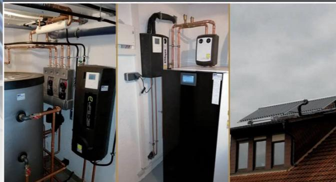
**Die Ölheizung wurde durch eine Pelletheizung mit Solaranlage ersetzt**
